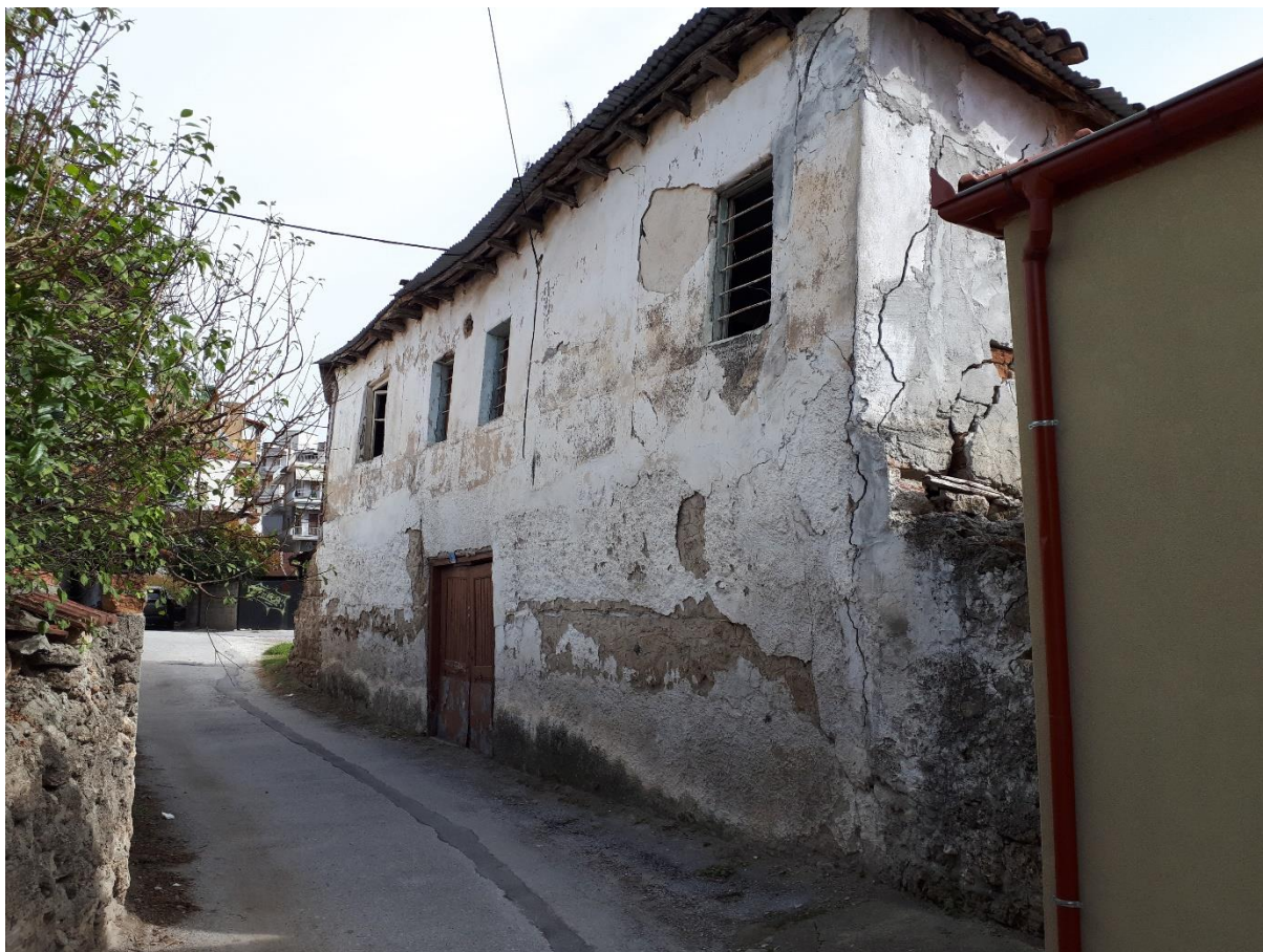
Φωτ. 2 Η βόρεια όψη (πρόσοψη) του κτίσματος.
