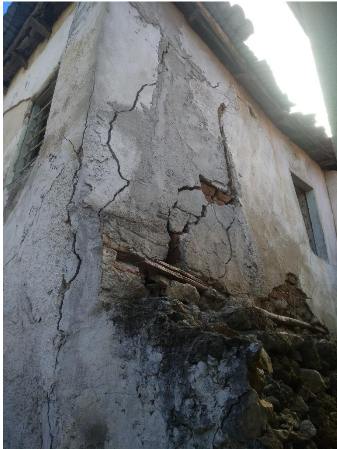
Φωτ. 5 Αποδιοργάνωση της βορειοδυτικής γωνίας.
