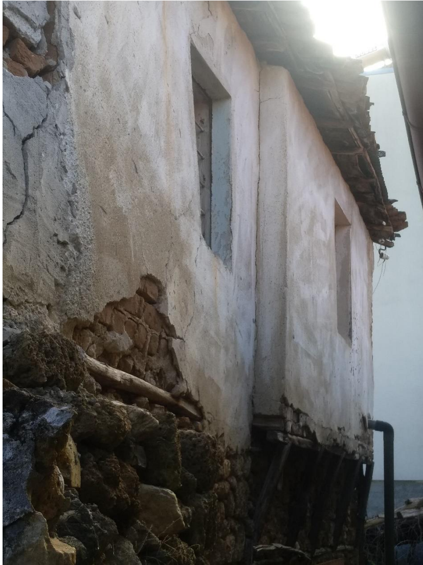
Φωτ. 7 Δυτική όψη του ορόφου.
