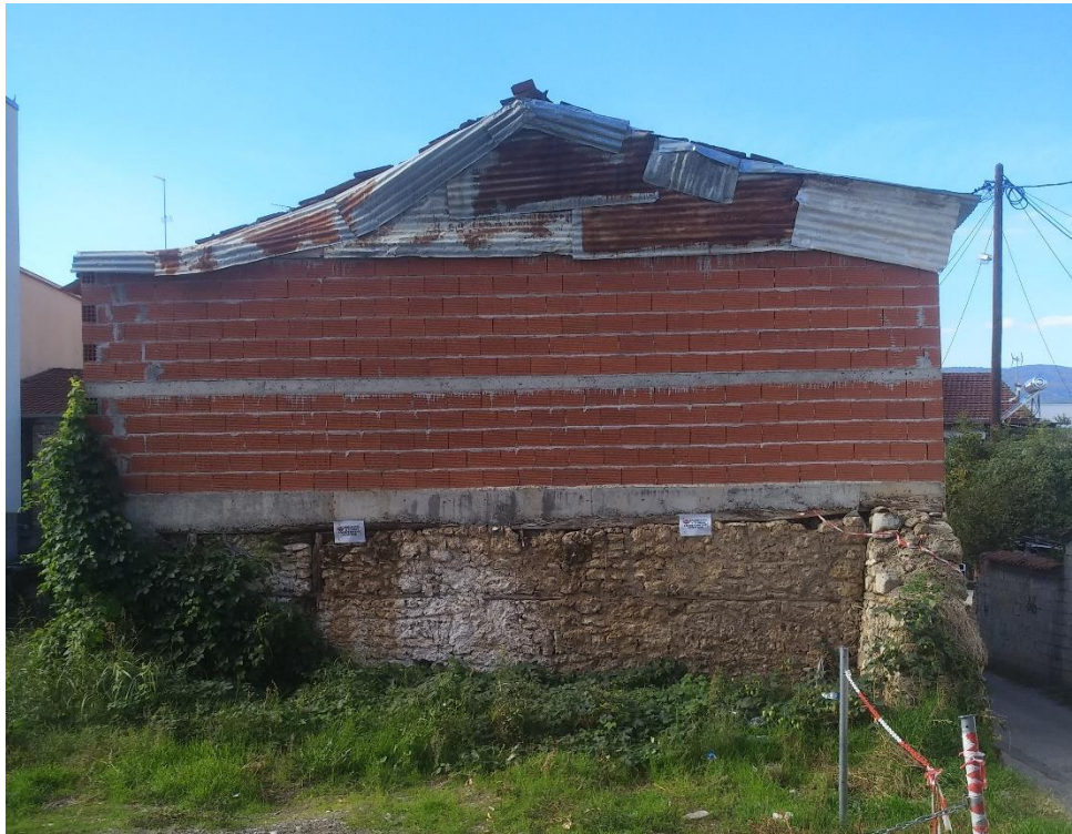
Φωτ. 3 Η ανατολική όψη του κτίσματος.
